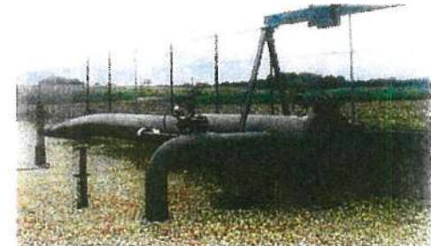
Poste de sectionnement enterré
