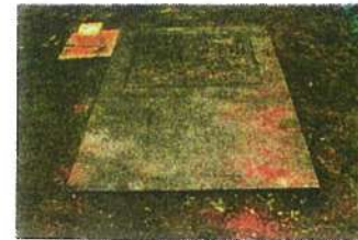
Poste de sectionnement enterré
