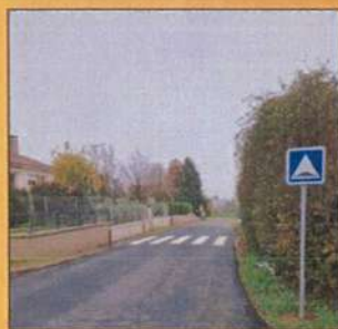
Aménagement Rue des Morels
